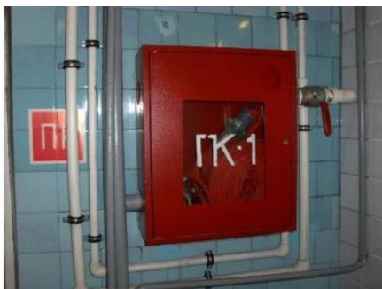
Внутренний противопожарный водопровод
